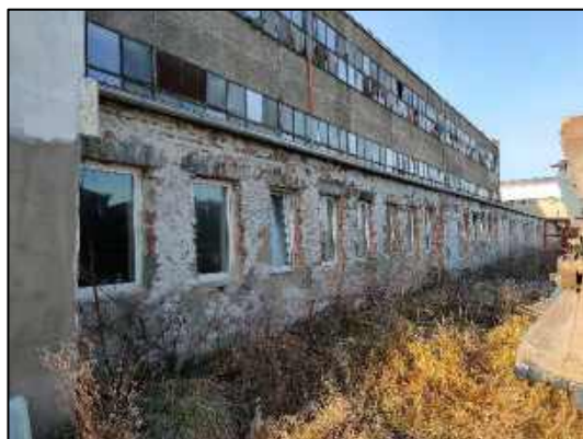
Pomieszczenia budynku socjalnego
