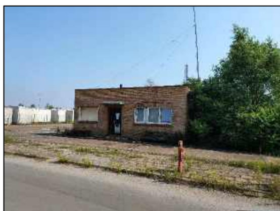
8. Budynek niemieszkalny - na działce nr 2/116 (portiernia) nr ewidencyjny 1333
