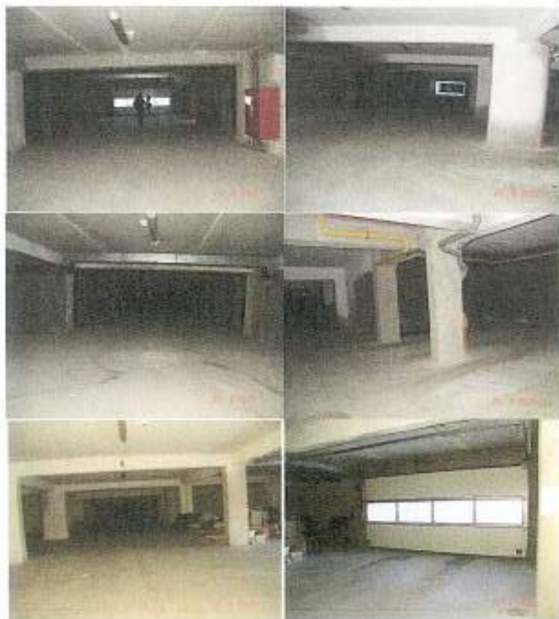
Budynek "A,B,C" garaże - poziom I i II - zdjęcia nr 26 (6szt)
