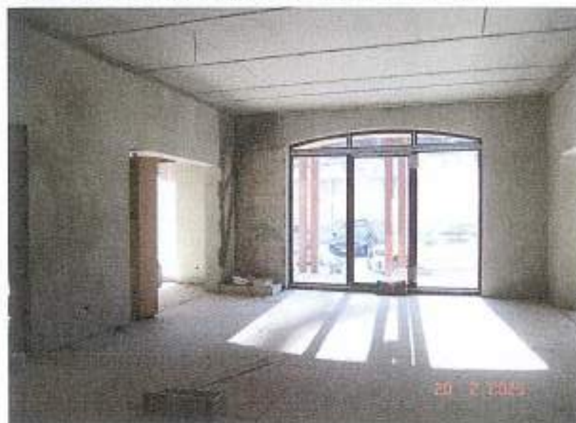
Budynek "A" część użytkowa - zdjęcia nr 13 - 16
