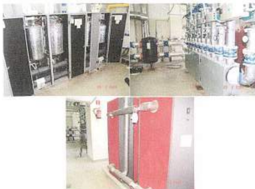
Budynek "A" kotłownia i magazyn wody - zdjęcia nr 27 - 28
